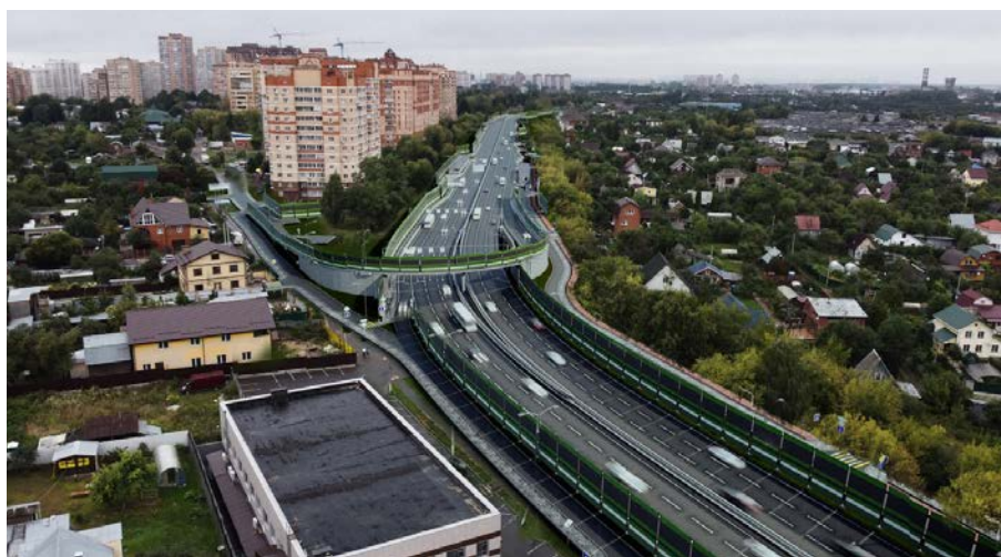
Реконструкция автомобильной дороги «Подход к городу Подольску» (км 0,0 — км 7,0) в городском округе Подольск Московской области (этап 1), выполненная с применением BIM-технологий
